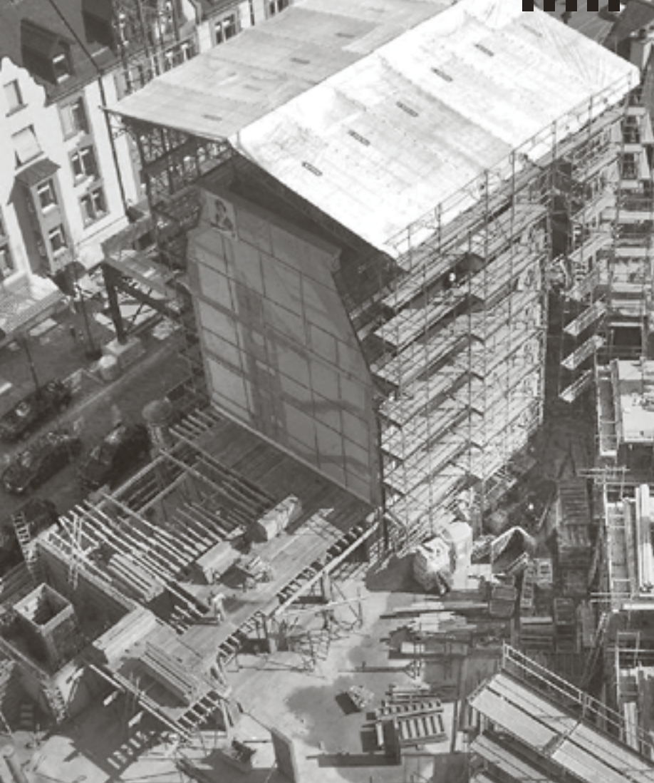
Baustelle von der Vogelperspektive
